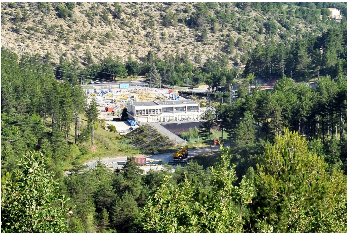
Figure 1. Installations de surface du stockage d'hydrocarbures liquides en cavité saline près de Manosque, Alpes-de-Haute-Provence (Source : Géostock)
